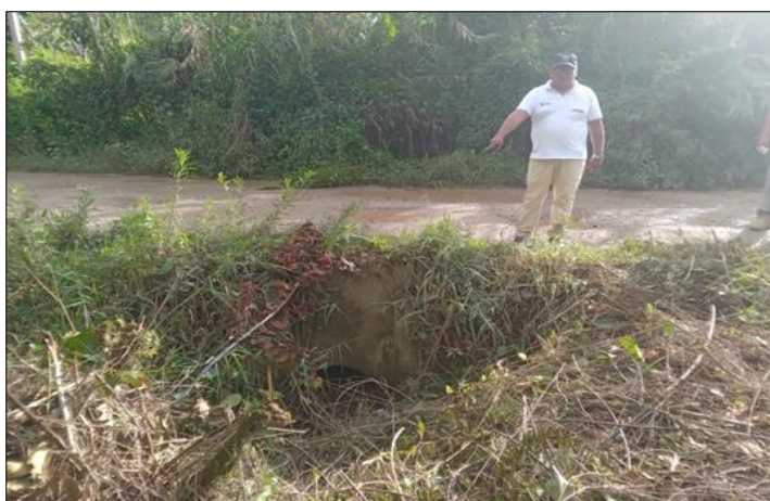
FIGURA N°02: QUEBRADA COLMATADA, REQUIERE MANTENIMIENTO DE LIMPIEZA Y DESCOLMATACION
